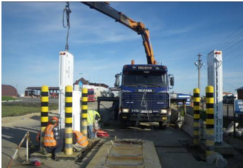
Byggingen av kjøretøysportaler ved grensestasjonen Kaerak i Kasakhstan..
