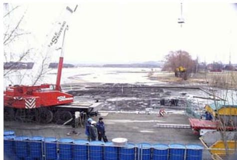
Oppgraving av forurensede sedimenter i Nitelva i 2000.
